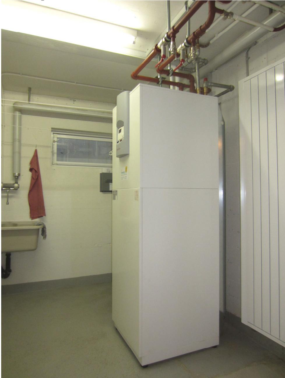
**Innengerät WPL25 mit Kombispeicher: Heizungsspeicher mit integriertem Boiler**
